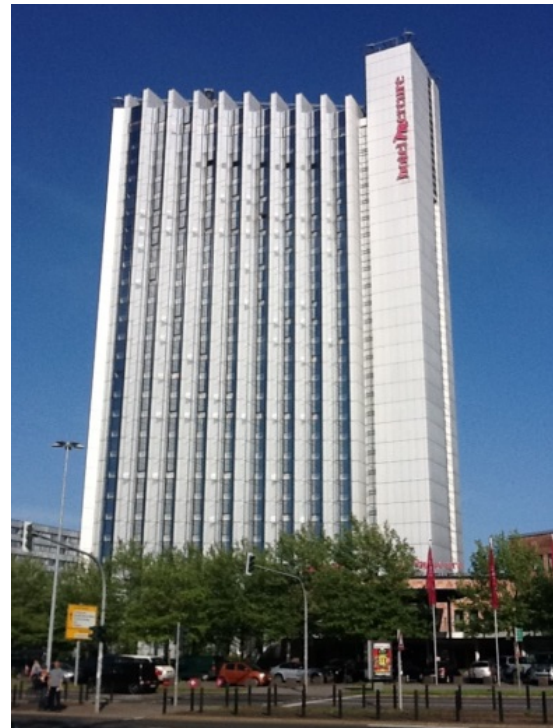
Abb. 4: Foto des Hotels, dessen Fahrstuhl für das Messbeispiel genutzt wurde (Mercure Hotel in Chemnitz)
